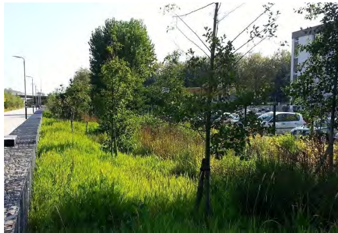
Bassin planté assurant la retenue et l'infiltration des eaux pluviales
