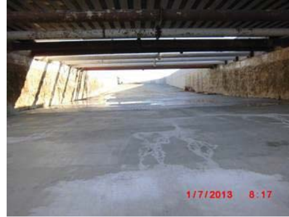
Exemple photo travaux trémie – Après réalisation du radier
