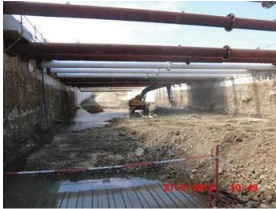
Exemple photo travaux trémie – Avant réalisation du radier
