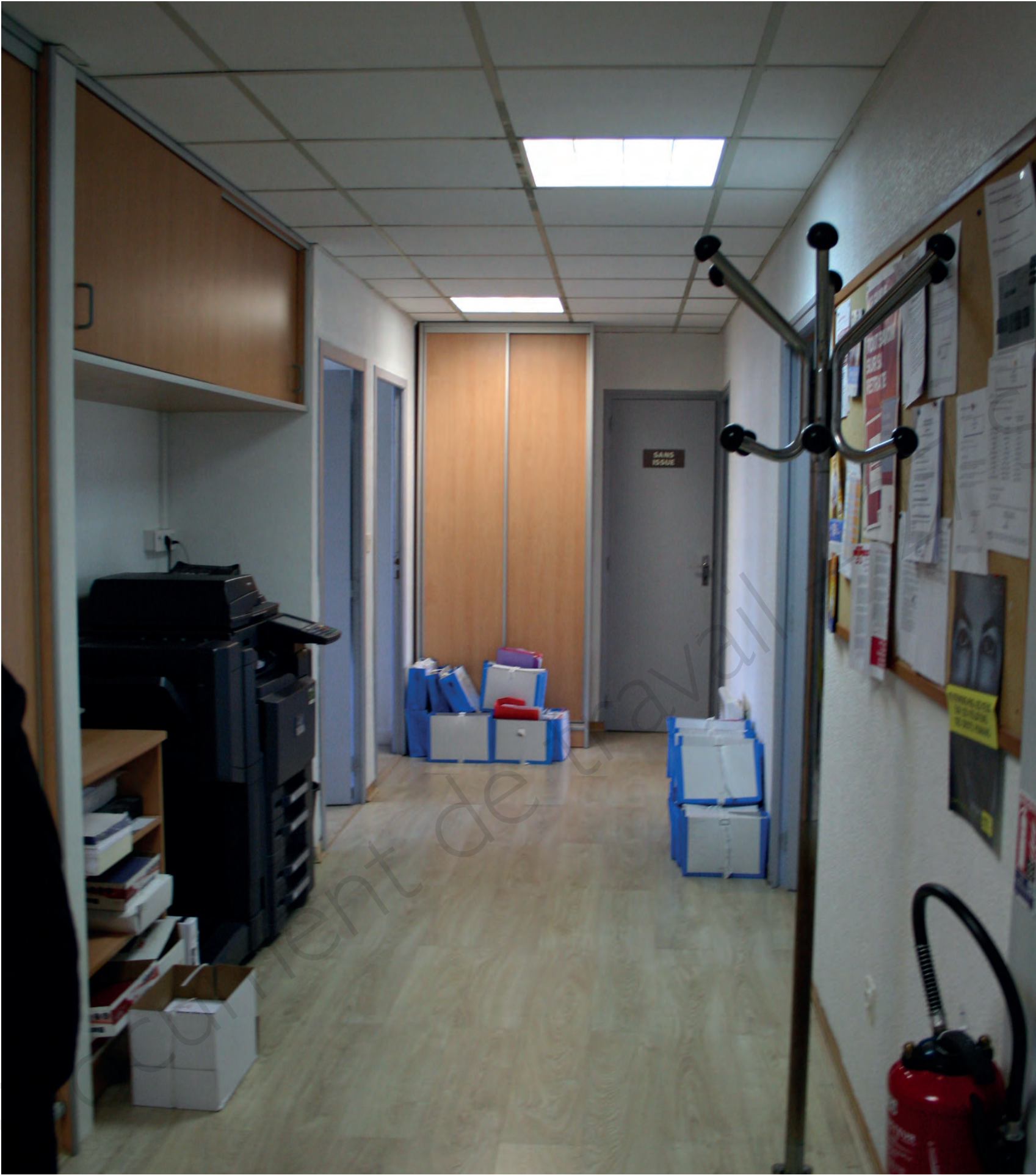
Rez-de-chaussée Hôtel de Ville extension (années 70) Une accessibilité qui fait défaut
