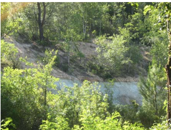
Des parois encore instables
