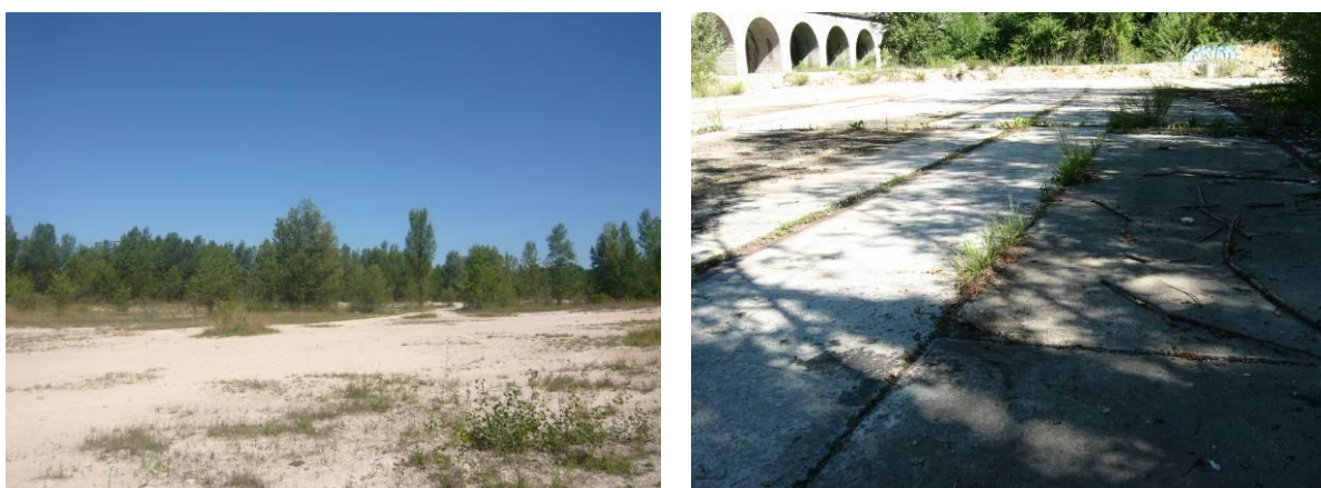
Figure 29 : Partie basse – sols dénaturés et dallages en béton
