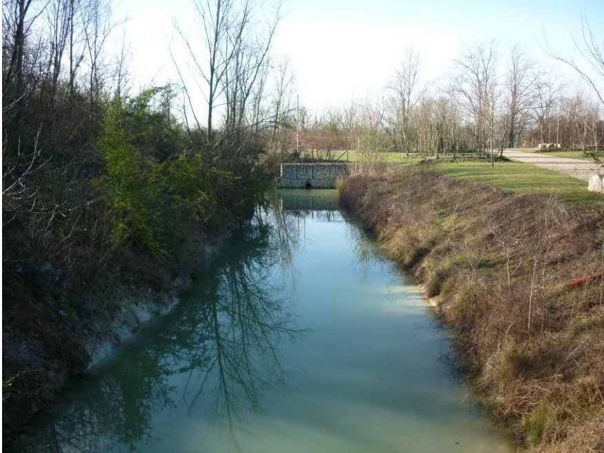
Ouvrage de rejet du trop-plein du lac de l'Ermitage
