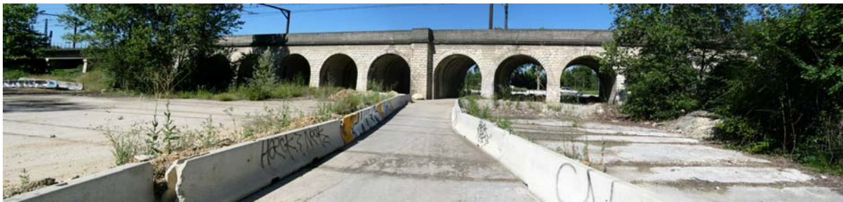
Vue sur le viaduc depuis le site
