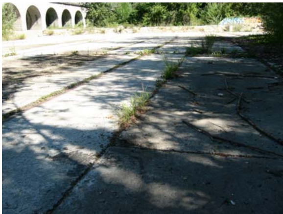
Dalle béton – motifs de rails – viaduc SNCF
