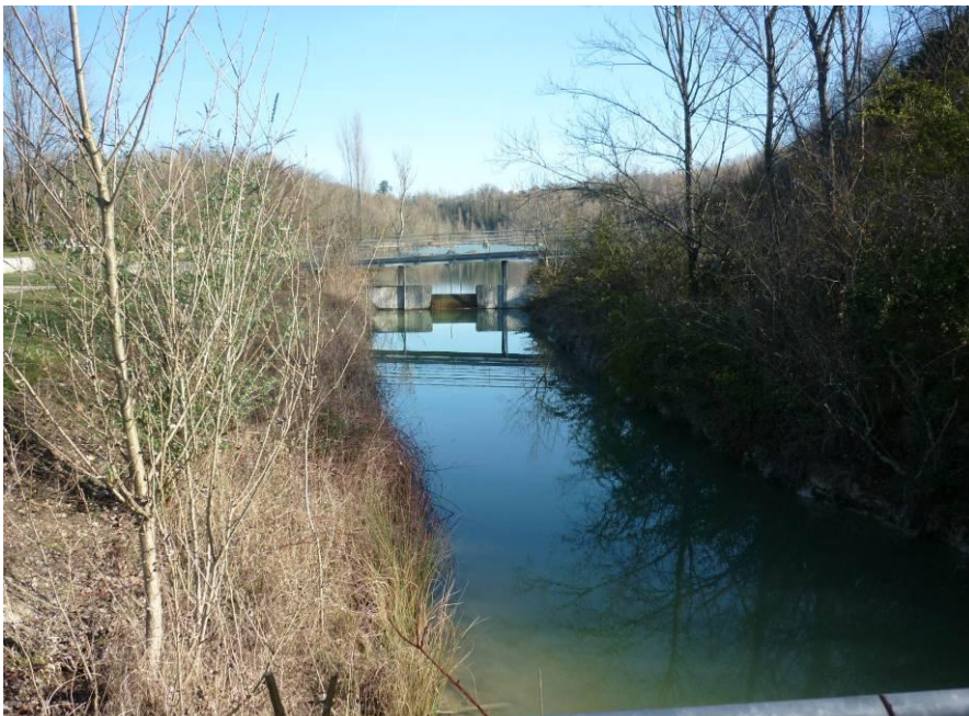
Muret en béton maintenant le niveau du lac de l'Ermitage
